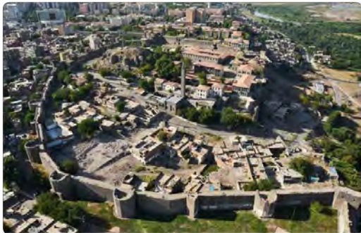
7.11. Görsel: Diyarbakır Kalesi
